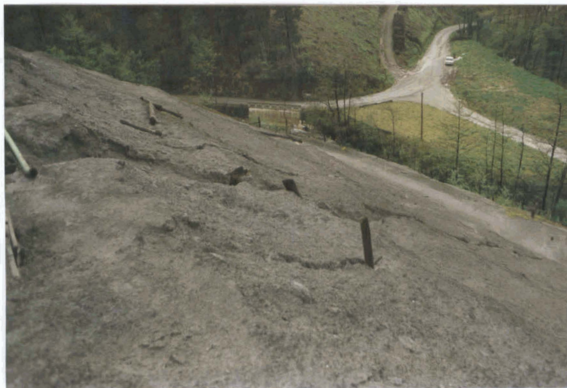
FOTO N° 5: Detalle del mismo talud visto desde la superficie de la balsa.
