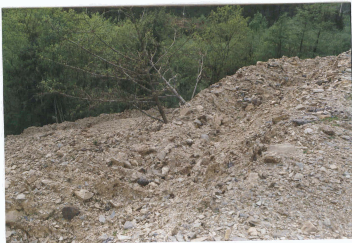
FOTO N° 9: Deslizamiento circular en talud de escombrera de mina de Pb - Zn - Fe, en Berástegui.
