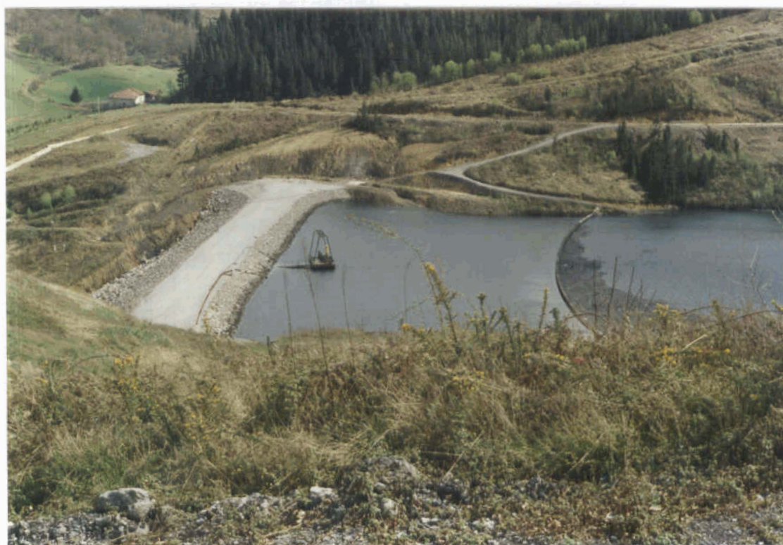
FOTO N° 17: Detalle de muro de la balsa, sobrenadante y recuperación del mismo.
