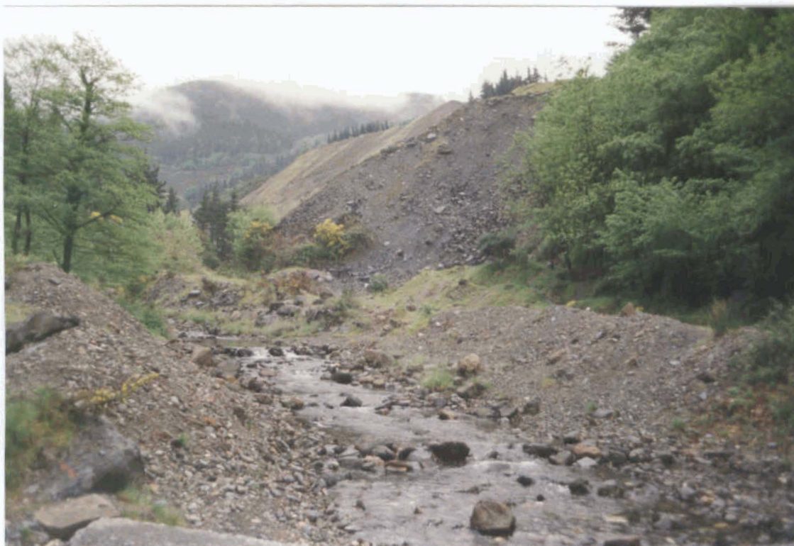
FOTO N° 7: Vista general de talud en escombrera en Arediturri, con aguas permanentes socavando su pié, y deslizamiento local en primer plano.
