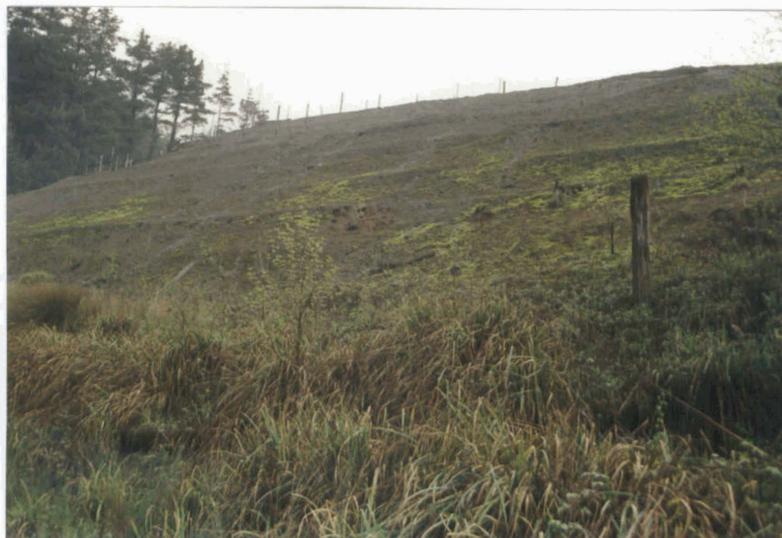
FOTO N° 19: Detalle de revegetación sobre las arenas del talud de la balsa de lodos de Legorreta.
